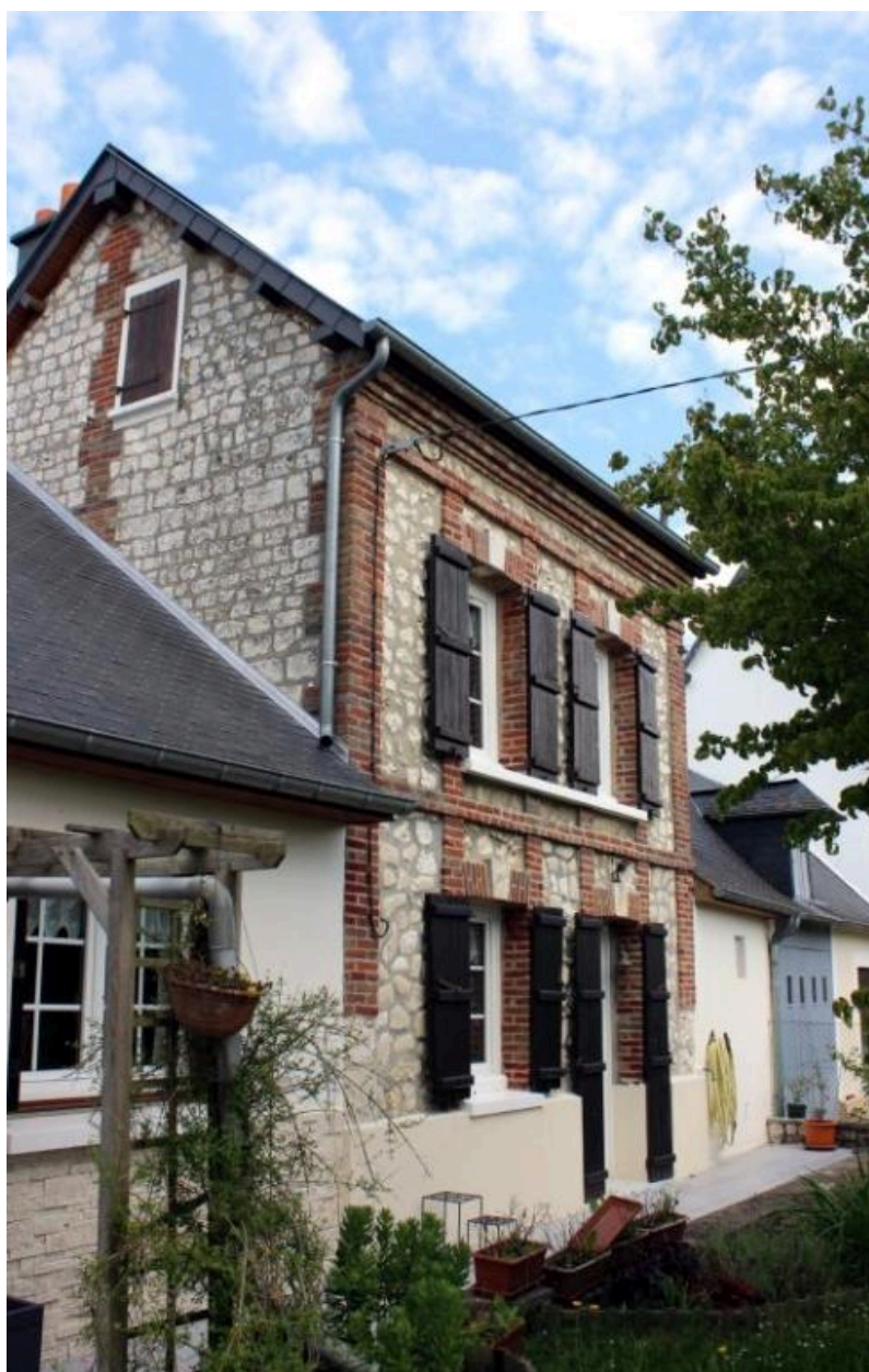
Maison à étage, hameau du Bourg Corblin, 206, rue du Bourg Corblin.
