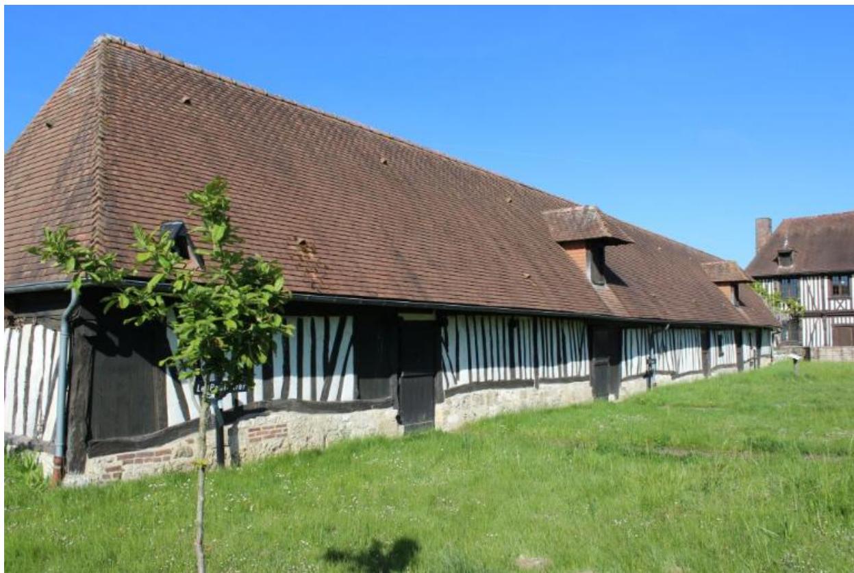
Ancienne grange et étable, angle sud-est.
