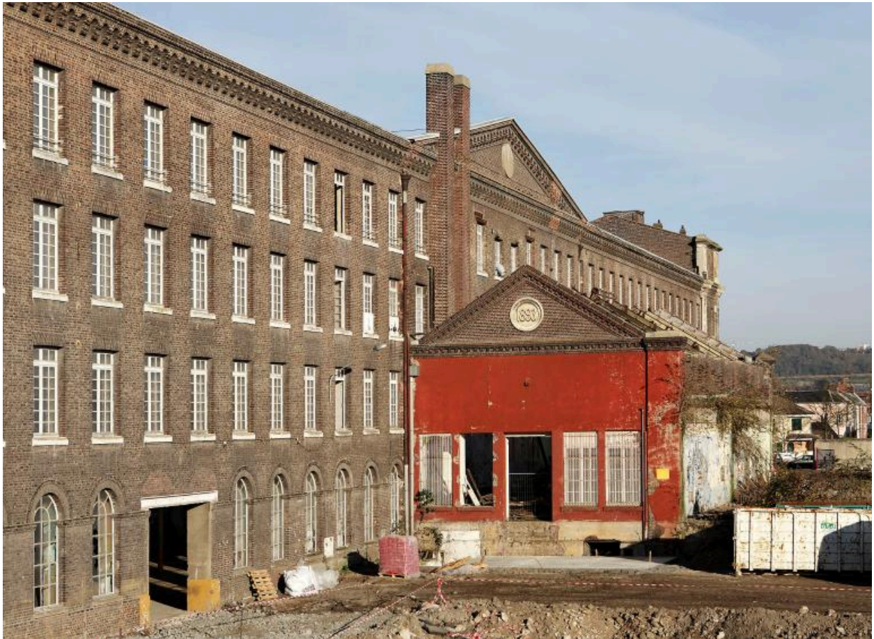
Vue de la façade Est de la filature avec la salle des machines attenante, depuis le Sud.
