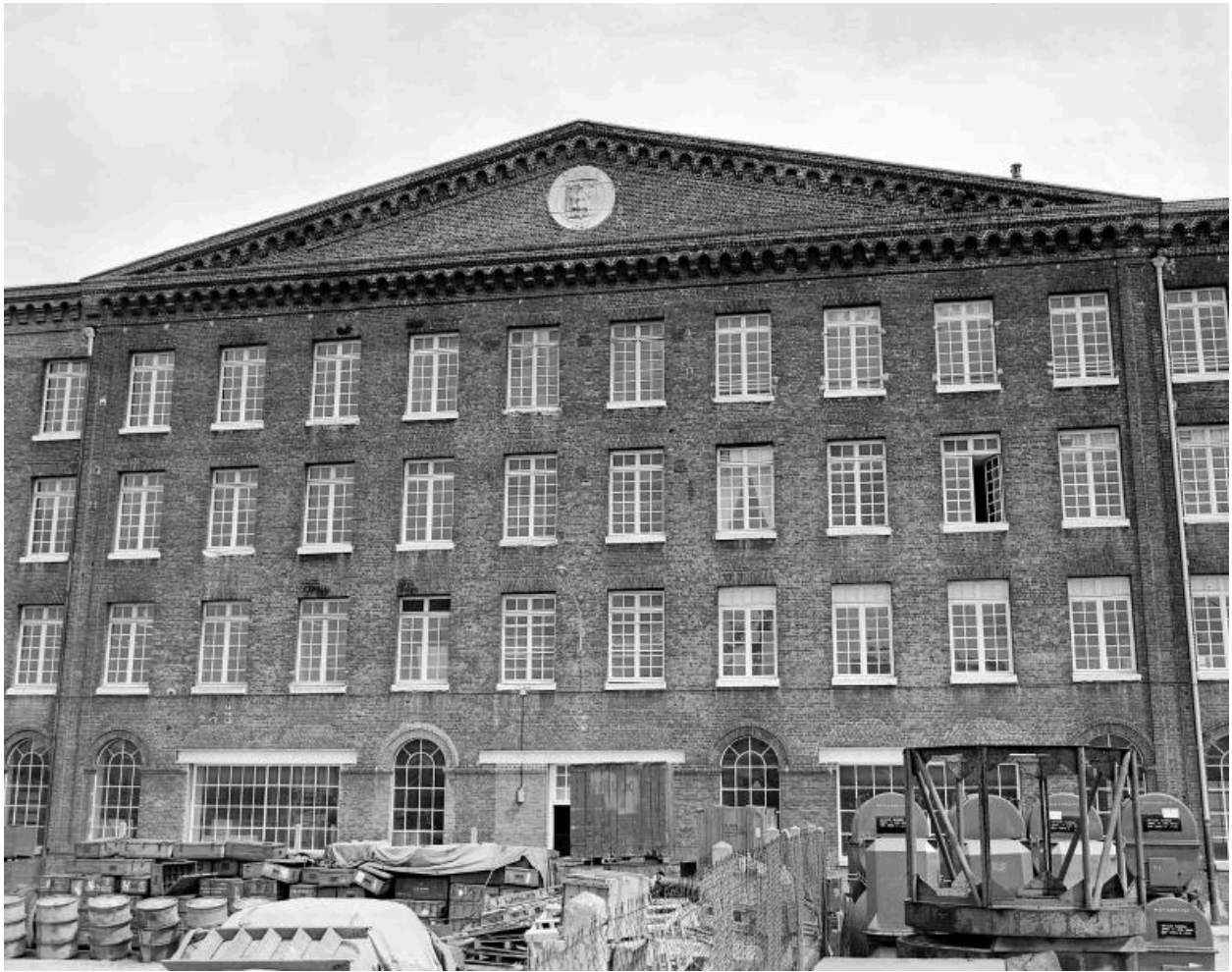
Vue de la façade Ouest de la filature, détail des travées centrales et du fronton.
