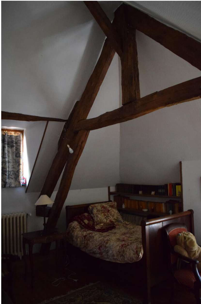
Logis, intérieur, vue de détail d'une ferme du comble de l'ancien logis (poinçon court).
