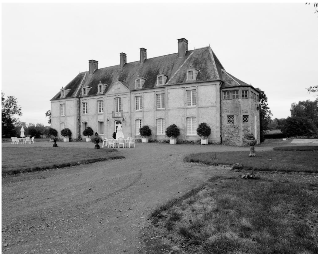
Logis, façade antérieure, vue prise du nord-est.
