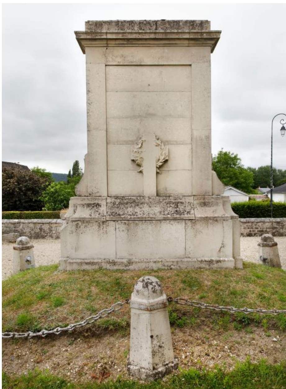
Face postérieure, détail du mur-stèle.
