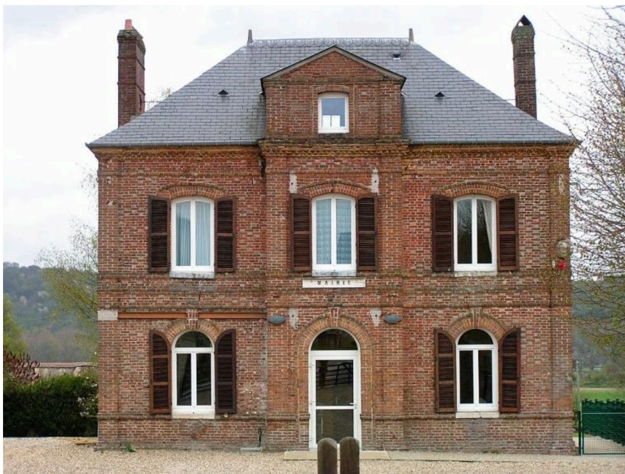
Façade ouest, vue en 2005.
