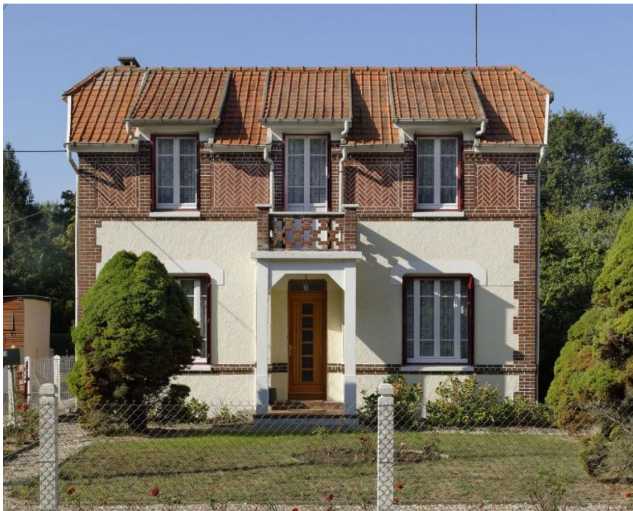
Maison, 802, rue du Petit Village.
