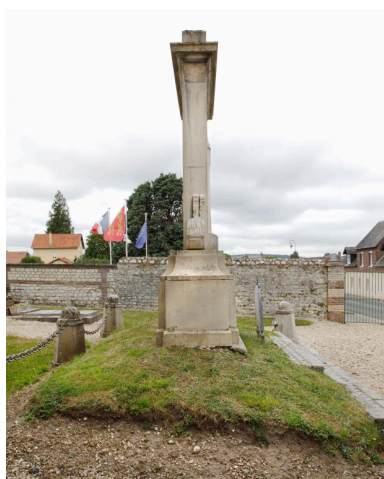
Face latérale droite, vue d'ensemble. Phot. Christophe Kollmann IVR28_20207600293NUC2A
