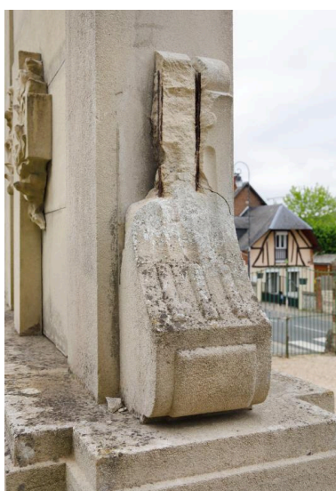
Aileron gauche, détail des altérations de la pierre artificielle. Phot. Christophe Kollmann
