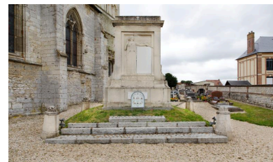
Face principale, vue d'ensemble. Phot. Christophe Kollmann IVR28_20207600300NUC2A
