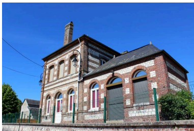
Pignon et salle de classe en prolongement, côté sud. Phot. Gaëlle Pottier IVR28_20197606300NUCA
