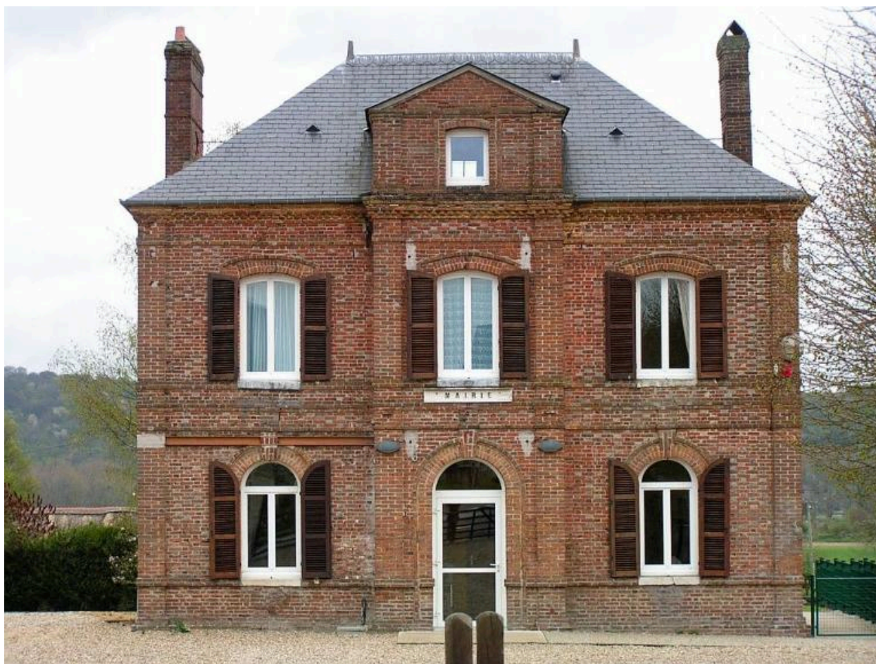
Façade ouest, vue en 2005.
