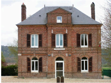
Façade ouest, vue en 2005. Phot. Emmanuelle Allaire IVR23_20057605021NUCA
