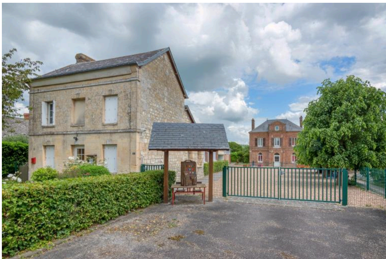
Vue d'ensemble depuis la route principale.
