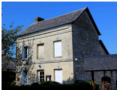
Maison en moellons calcaire à l'entrée de la cour de récréation, angle sud-ouest. Phot. Gaëlle Pottier IVR28_20197606301NUCA
