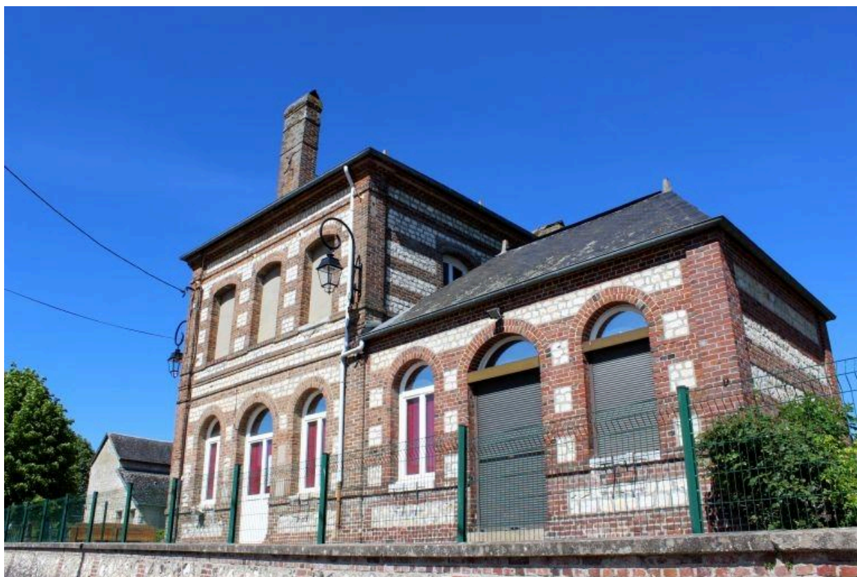
Pignon et salle de classe en prolongement, côté sud.
