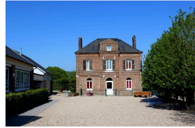
Façade ouest, vue depuis la cour de récréation. Phot. Gaëlle Pottier IVR28_20197606302NUCA
