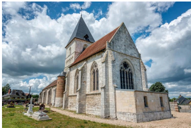
Vue sur le chevet, angle sud-est. Phot. Marc Costil IVR28_20197606413NUCA
