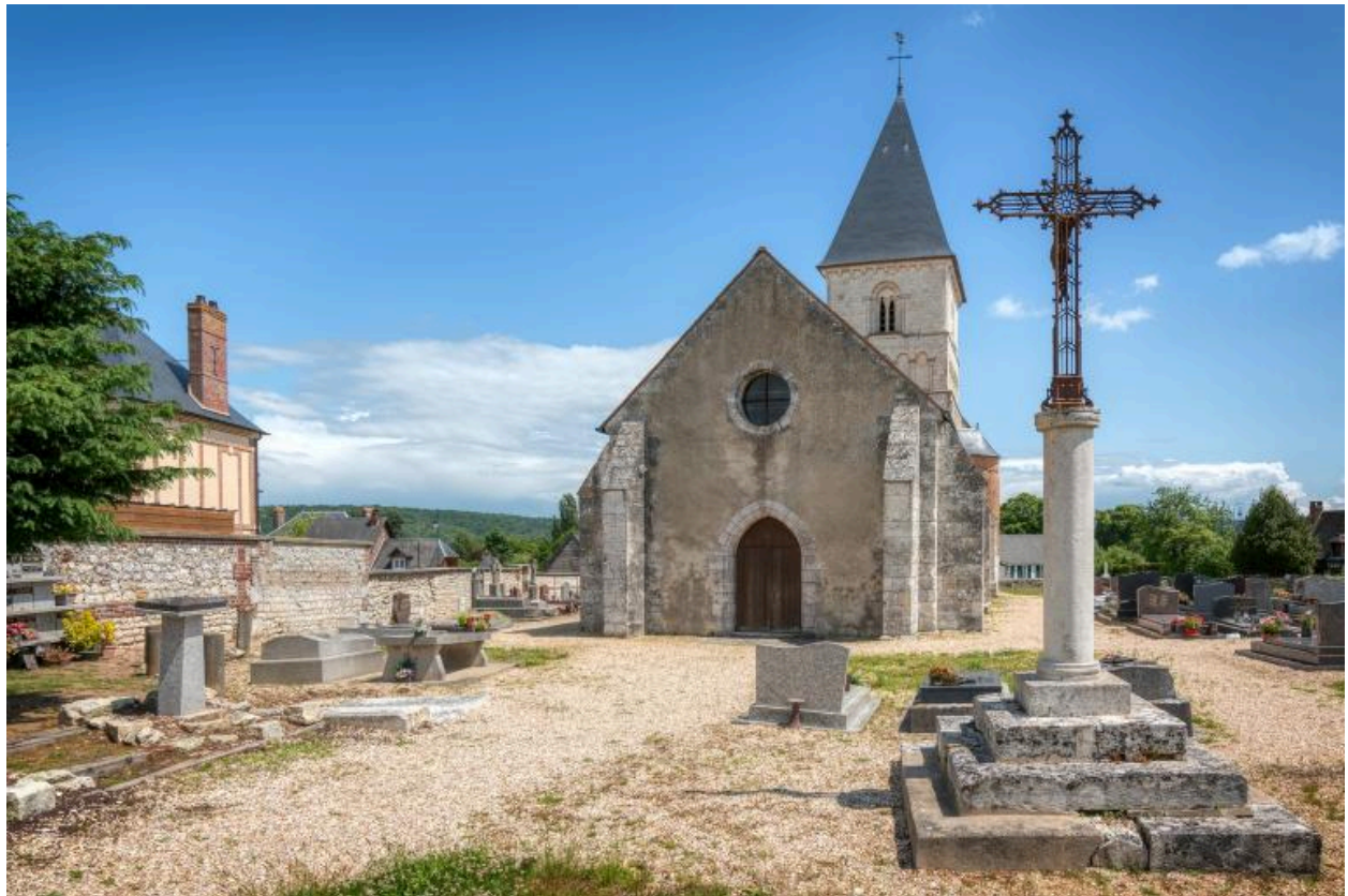
Vue sur la façade occidentale avec calvaire au premier plan.
