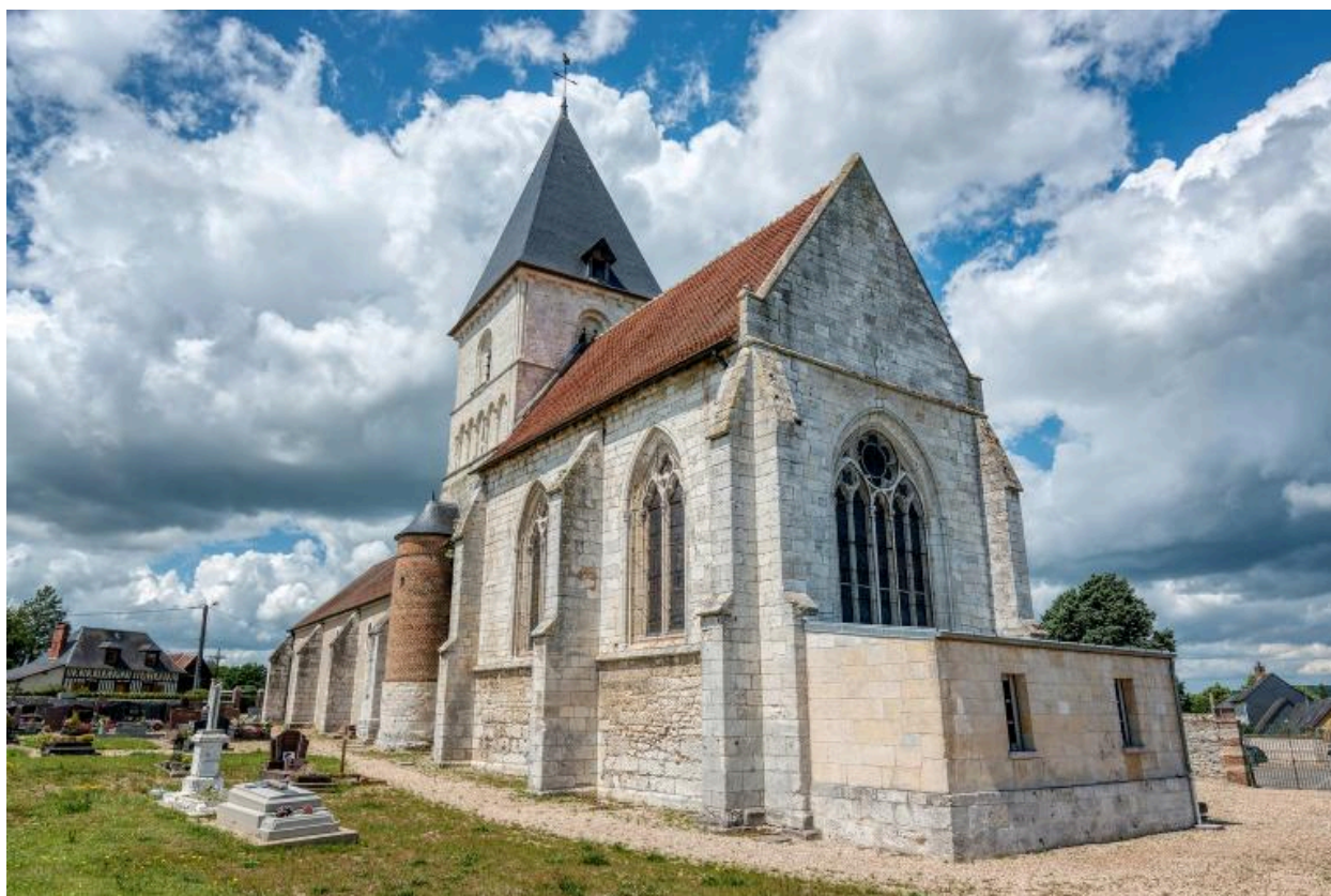
Vue sur le chevet, angle sud-est.
