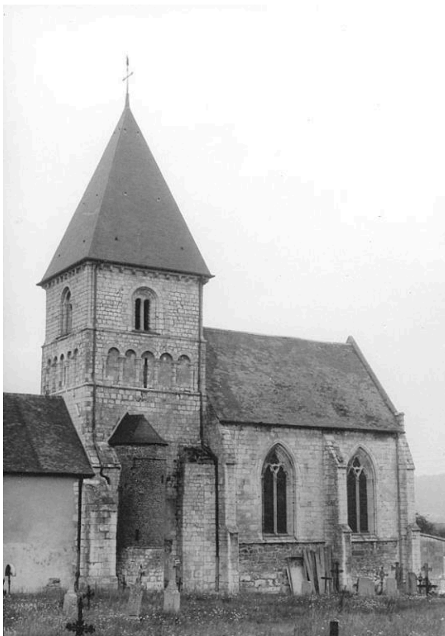
Choeur et clocher, côté sud.- Photographie ancienne, inventaire du Parc, 1972.
