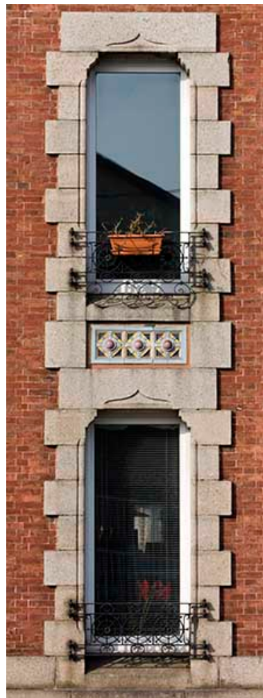
Façade sur rue. Détail d'une travée. Phot. Manuel de Ruyg IVR25_20095000527NUC2A
