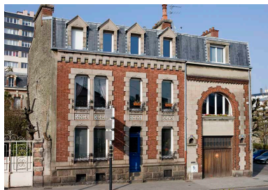
Façade sur rue. Phot. Manuel de Ruyg IVR25_20095000525NUC2A
