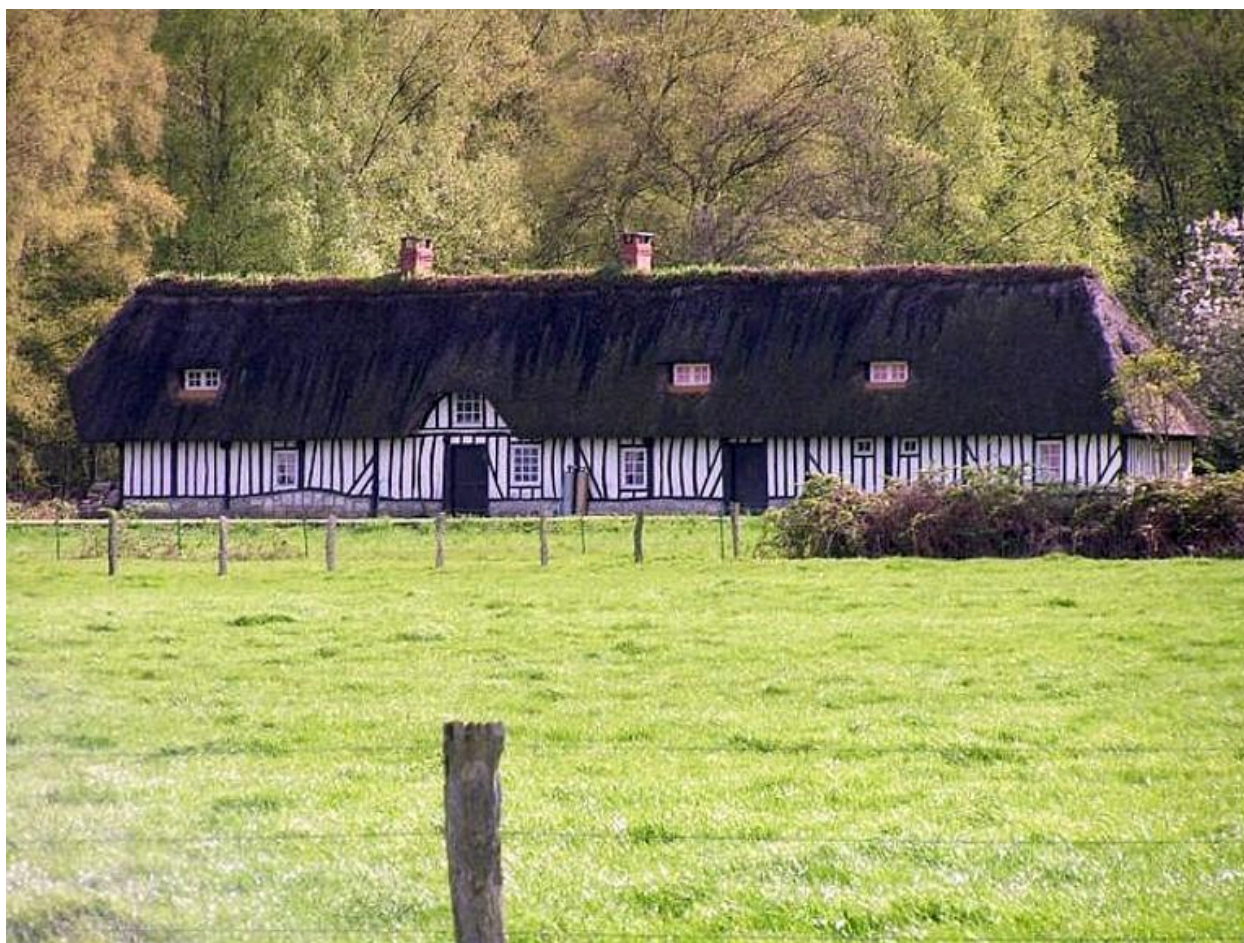
Chaumière, vue depuis la rue des Bruyères en 2005, le bord du Mort, chemin des pilotes.
