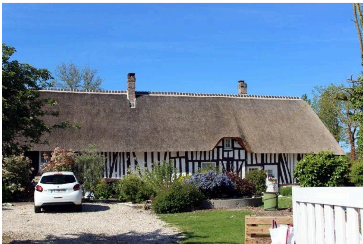
Chaumière, bourg, 137, rue du Petit Pont.
