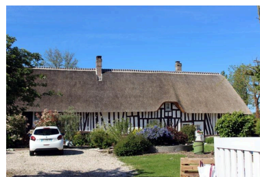
Chaumière, bourg, 137, rue du Petit Pont. Phot. Gaëlle Pottier IVR28_20197606248NUCA
