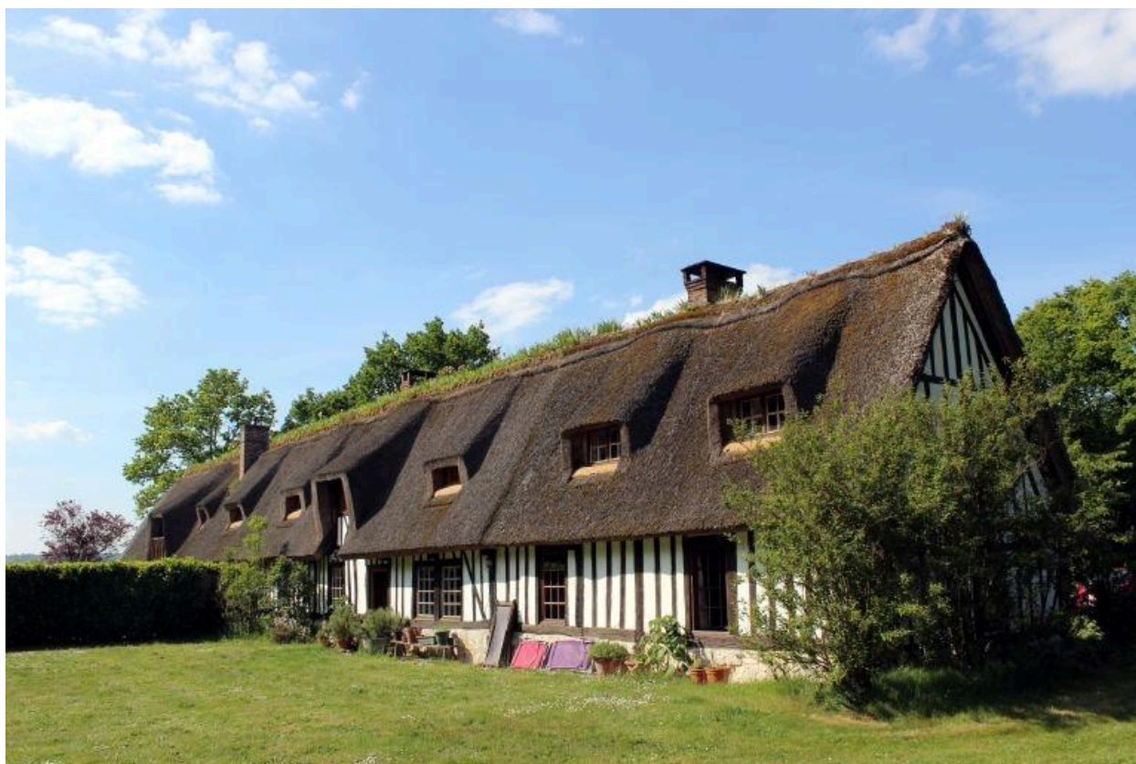
Chaumière entièrement remontée, le bord du Mort, rue des Bruyères.
