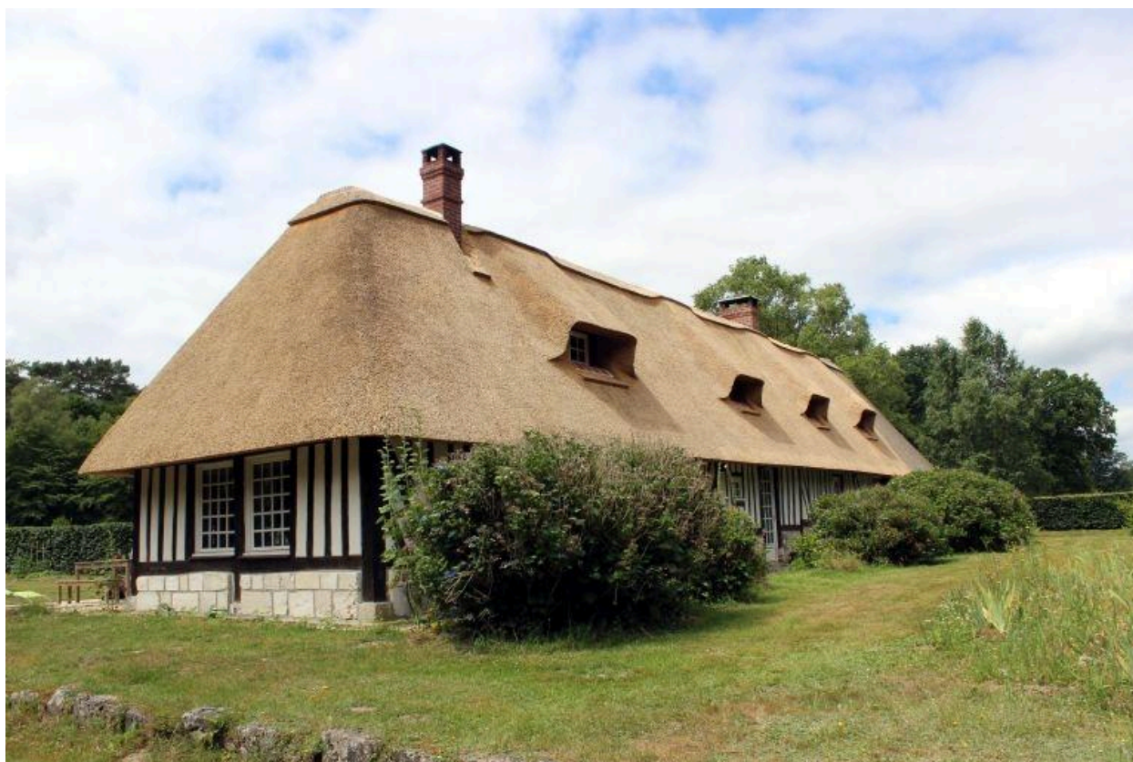
Chaumière, angle nord-est, le bord du Mort, 1255, rue des Bruyères.
