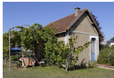
Ancien bureau, angle sud-est. Phot. Christophe Kollmann IVR28_20197601876NUCA
