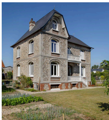
Maison du directeur, angle sud-est. Phot. Christophe Kollmann IVR28_20197601871NUCA
