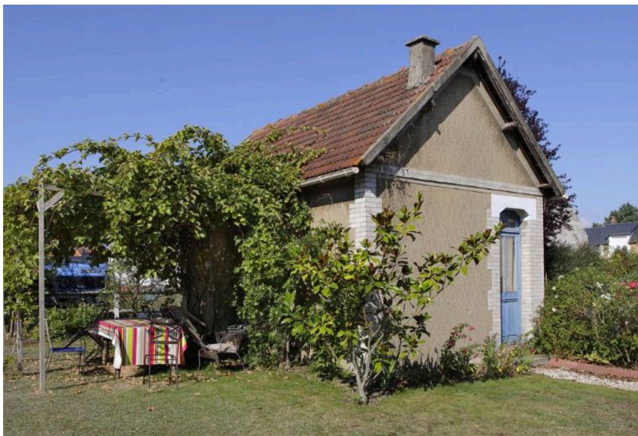
Ancien bureau, angle sud-est.
