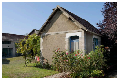
Ancien bureau, angle nord-est. Phot. Christophe Kollmann IVR28_20197601875NUCA
