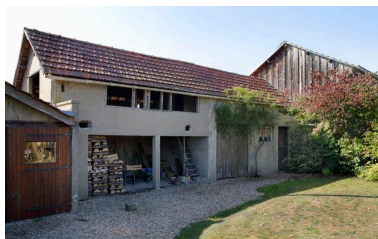
Ancien bâtiment d'exploitation. Phot. Christophe Kollmann IVR28_20197601874NUCA
