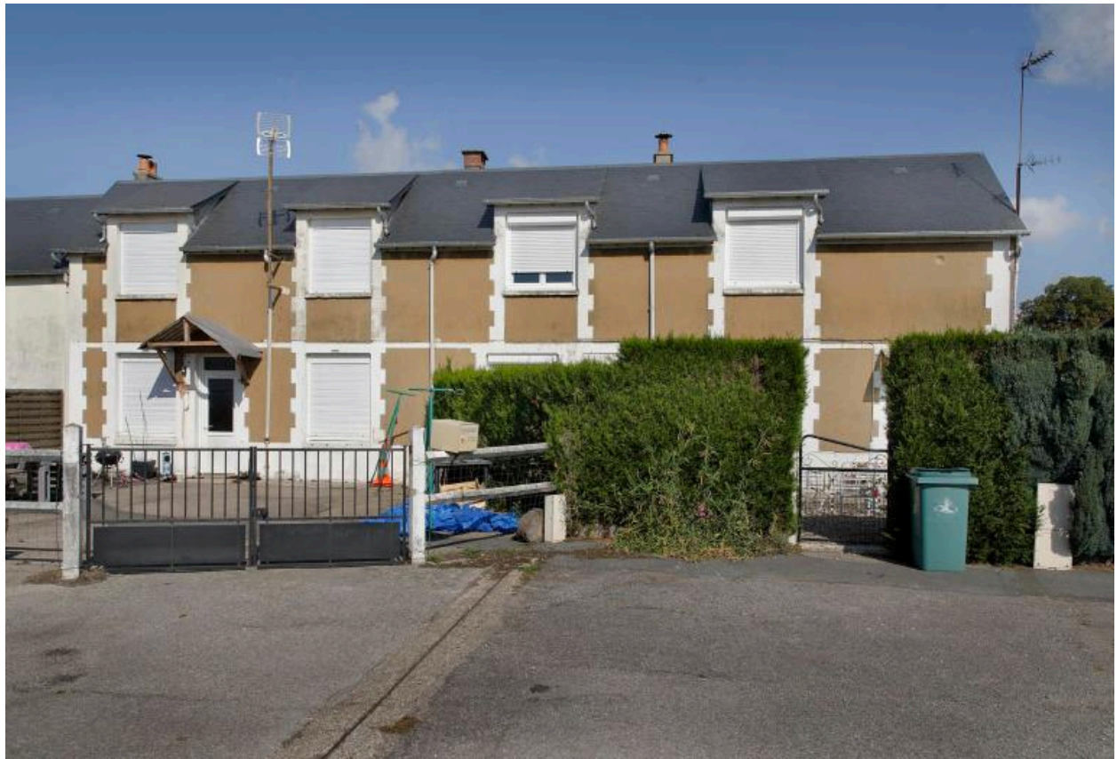
Anciens logements des ouvriers.
