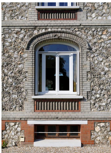
Maison du directeur, détail d'une baie. Phot. Christophe Kollmann IVR28_20197601873NUCA
