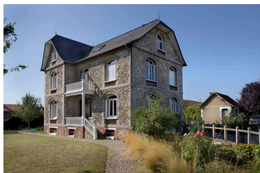
Maison du directeur, angle nord-est. Phot. Christophe Kollmann IVR28_20197601879NUCA
