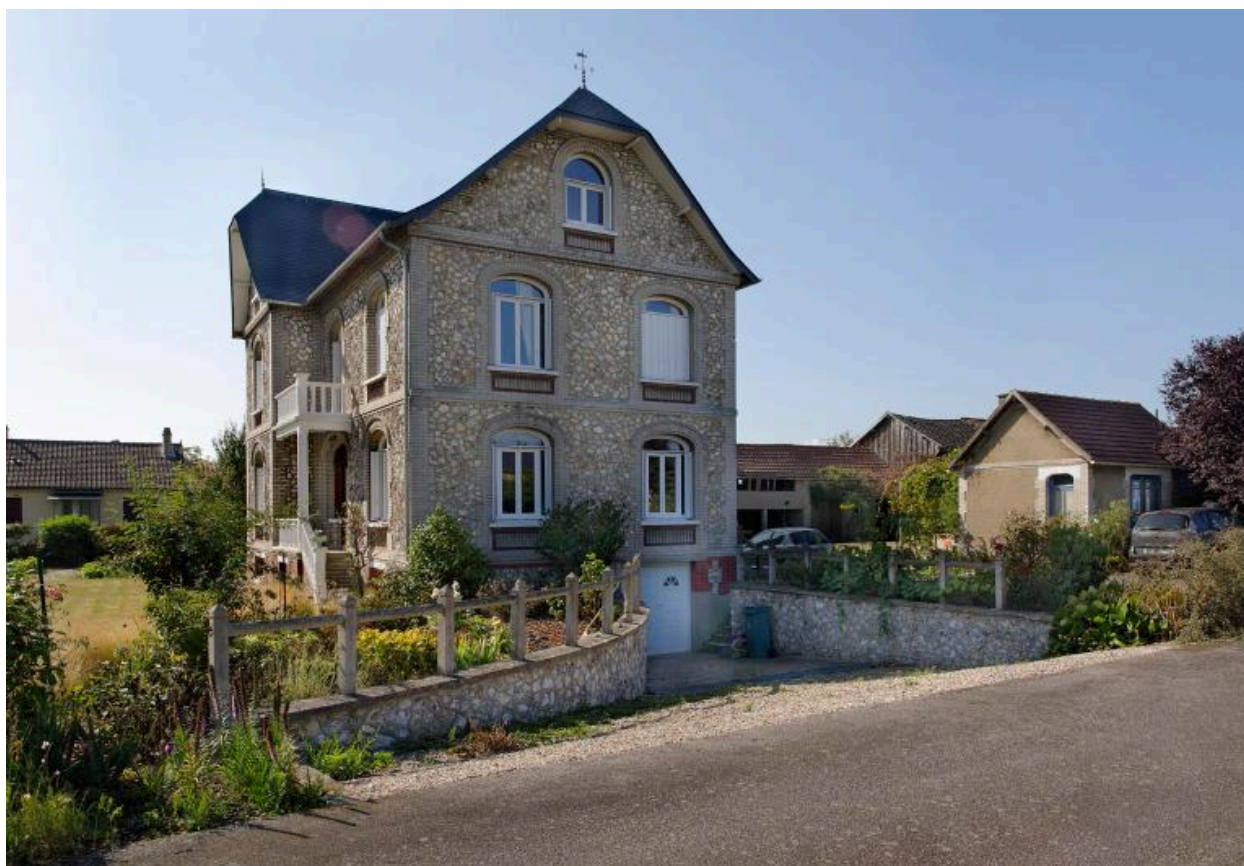
Maison du directeur, pignon nord.
