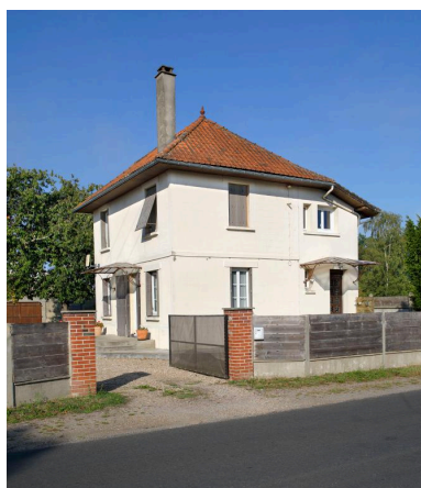
Ancienne maison du gardien. Phot. Christophe Kollmann IVR28_20197601574NUCA
