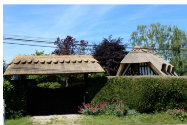
Porche d'entrée. Phot. Gaëlle Pottier IVR28_20197606357NUCA
