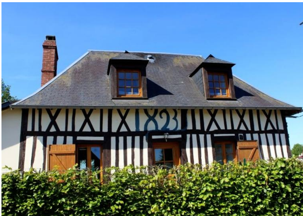
Maison, façade est.
