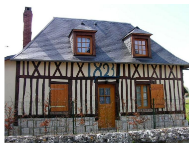
Maison, vue en 2005. Phot. Emmanuelle Allaire IVR23_20057605019NUCA
