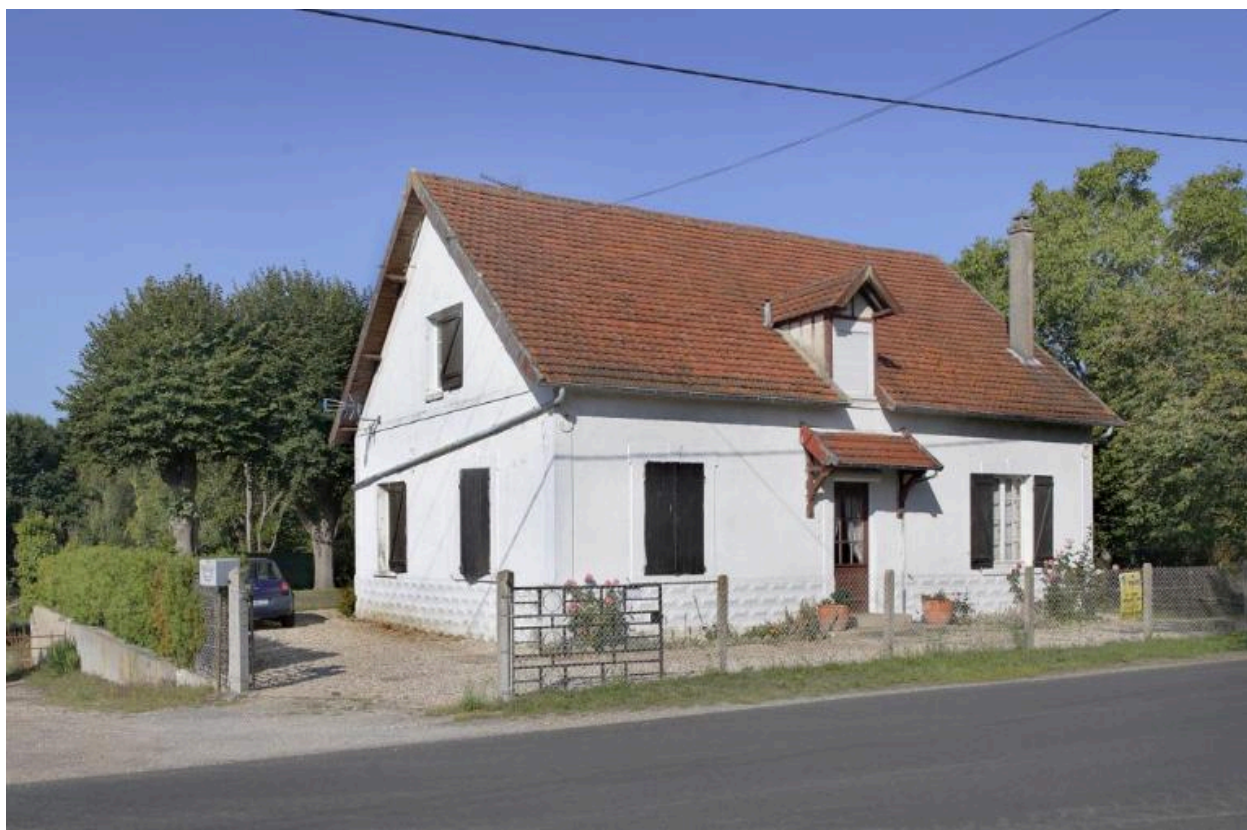
Maison associée à l'ancienne carrière de granulats.
