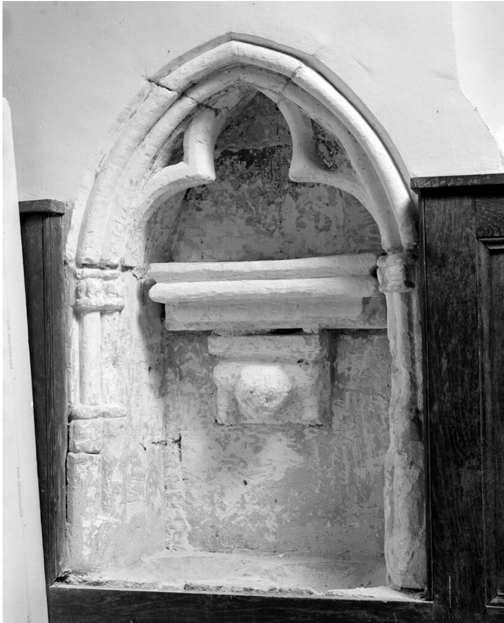
Crédence lavabo, vue d'ensemble
